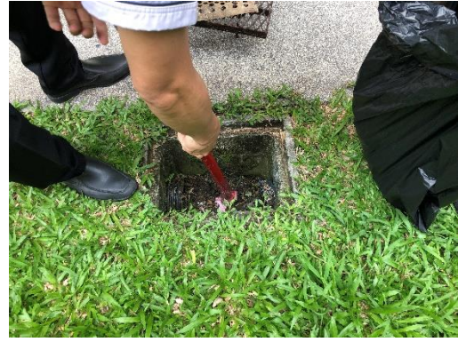
ตรวจสอบท่อระบายน้ำและขุดลอกตะกอนดิน ภาพที่ 2.2-7 (ต่อ) ระบบระบายน้ำและป้องกันน้ำท่วม
